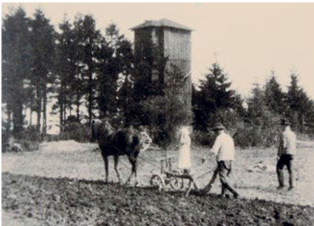
Erster Hochbehälter von 1926 mit einem Fassungsvermögen von ca. 20 cbm
